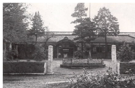
↑ S.32校舎と門柱(石柱)
